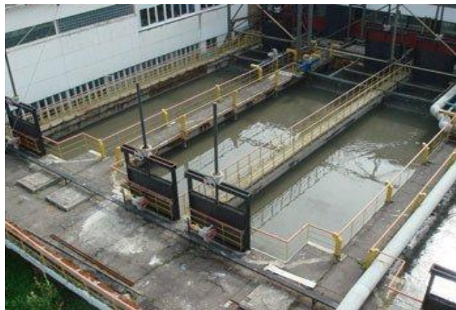
სურათი 8.2. ჰორიზონტალური სალექარი - ქვიშაღამჭერი მუშაობის პრინციპი იხილეთ https://www.youtube.com/watch?v=OWh8NGTR4OQ
