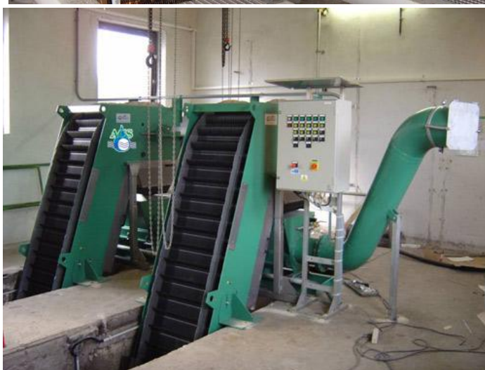
სურათი 8.1. ფარის სისტემა ჩამდინარე წყლების გაწმენდაში მუშაობის პრინციპი იხილეთ https://www.youtube.com/watch?v=xpvBjG0JumA
