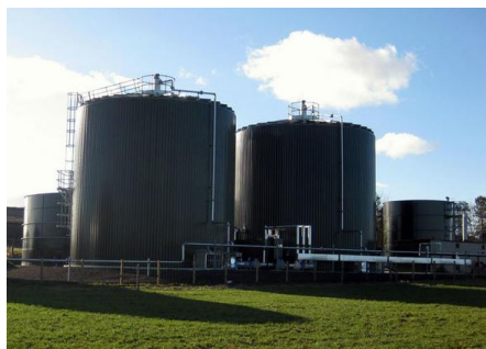
სურათი 8.11. ჩამდინარე წყლის გაწმენდის ნაგებობები, სადაც მიმდინარეობს ანაერობული პროცესი
