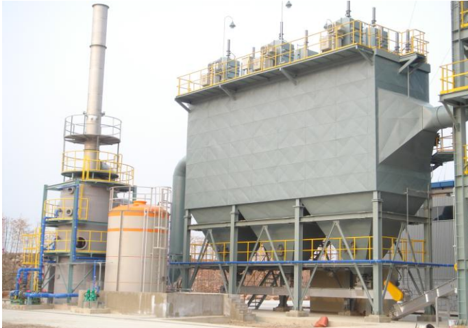
სურათი 7.12. გამწმენდი მოწყობილობა ელექტროფილტრის კონსტრუქციით
