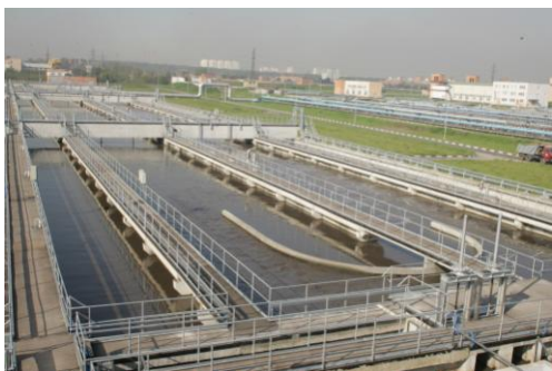
სურათი 8.10. ჩამდინარე წყლის გაწმენდის ნაგებობები, სადაც მიმდინარეობს აერობული პროცესი
