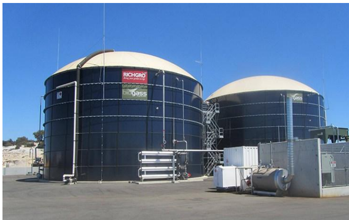
სურათი 8.9. ანაერობული რეაქტორი და ნივთიერებათა ნაკადი ჩამდინარე წყლის ანაერობული გაწმენდის დროს
