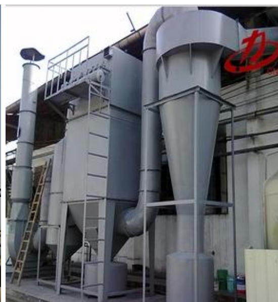
სურათი 7.6. ციკლონის კონსტრუქციები სხვადასხვა სამრეწველო საწარმოში
