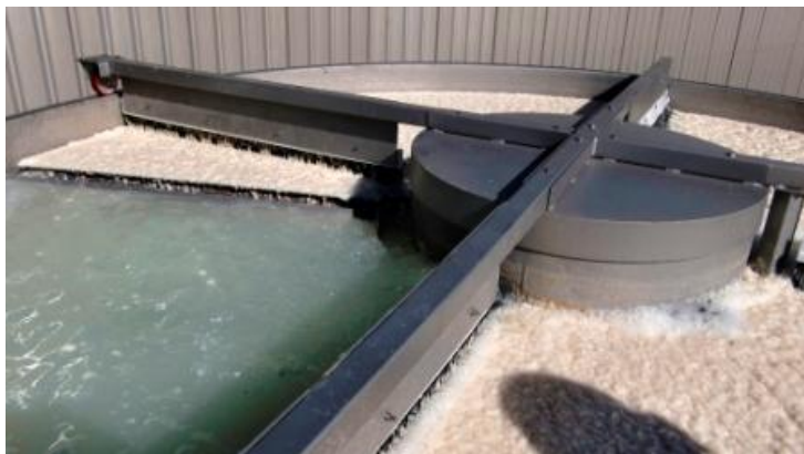
სურათი 8.7. ფლოტაციის პროცესი ჩამდინარე წყლების გაწმენდაში
