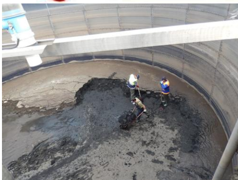
სურათი 8.14. შლამის წარმოქმნა და მოცილება ჩამდინარე წყლის გაწმენდის ნაგებობაზე
