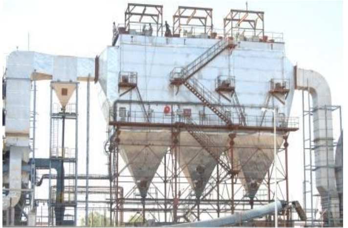
სურათი 7.12. გამწმენდი მოწყობილობა ელექტროფილტრის კონსტრუქციით
