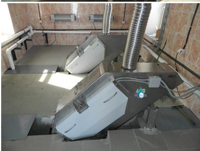
სურათი 8.1. ფარის სისტემა ჩამდინარე წყლების გაწმენდაში მუშაობის პრინციპი იხილეთ https://www.youtube.com/watch?v=xpvBjG0JumA
