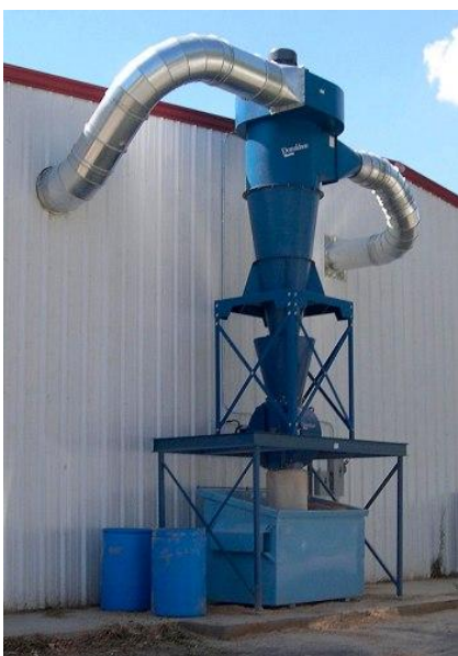
სურათი 7.6. ციკლონის კონსტრუქციები სხვადასხვა სამრეწველო საწარმოში
