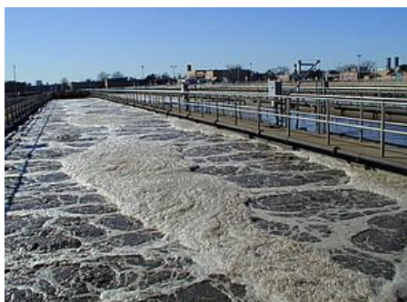
სურათი 8.10. ჩამდინარე წყლის გაწმენდის ნაგებობები, სადაც მიმდინარეობს აერობული პროცესი
