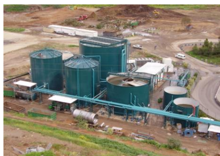
სურათი 8.11. ჩამდინარე წყლის გაწმენდის ნაგებობები, სადაც მიმდინარეობს ანაერობული პროცესი
