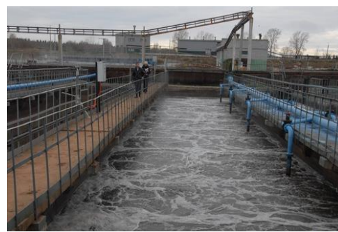
სურათი 8.10. ჩამდინარე წყლის გაწმენდის ნაგებობები, სადაც მიმდინარეობს აერობული პროცესი
