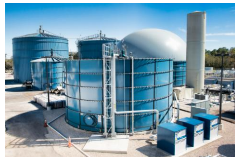
სურათი 8.11. ჩამდინარე წყლის გაწმენდის ნაგებობები, სადაც მიმდინარეობს ანაერობული პროცესი
